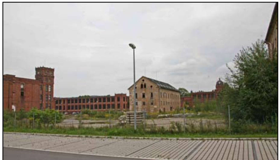
Noch braucht es viel Fantasie, aber hier soll und wird sie entstehen: die neue Mitte von Flöha mit Handelszentrum, Marktplatz, Mehr-Generationen-Bebauung und Gastronomie
