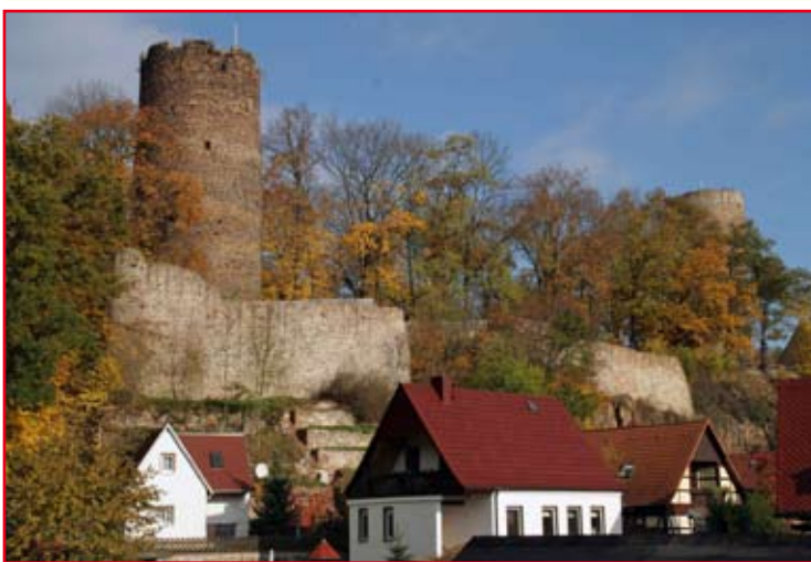
Bild darunter: Die imposante Burgruine mit den beiden romanischen Rundtürmen auf dem Burgberg des Städtchens Kohren-Sahlis im Landkreis Leipzig. Kohren-Sahlis ist vor allem bekannt durch seine lange Töpfertradition.
