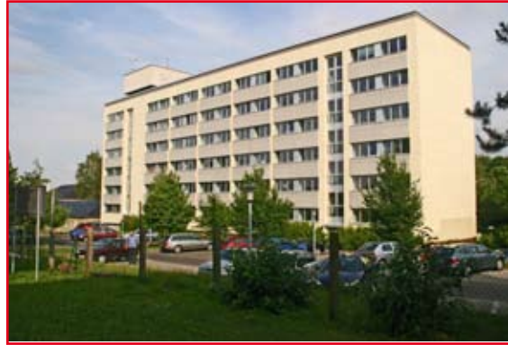
Häuser des Landratsamtes in Freiberg (oben) und Mittweida. In Freiberg soll der Bereich Ordnung und Scherheit konzentriert werden, in Mittweida der soziale Bereich und in Döbeln die Bereiche Kreisentwicklung und Bauen.
