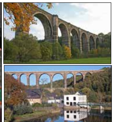
In Folge -11- unserer Serie „mittelsächsischer Knüller“ berichteten wir über Bauwerke der Eisenbahngeschichte. Oben der Hetzdorfer, unten der Göhrener Viadukt.
